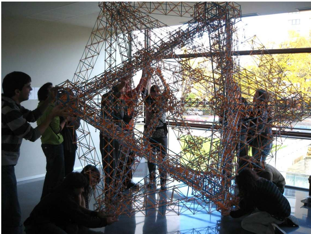
Figura 15. La escultura, que ya ha alcanzado los tres metros de diámetro, tiene ya la suficiente rigidez como para ser girada. Todos colaboran en la rotación, uno de los momentos más delicados del montaje. El giro facilitará el trabajo sobre las partes inaccesibles del poliedro.
